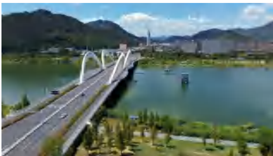
北之江过江通道（公望大桥）照片
