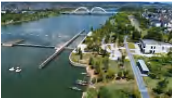
上堵坝区域全景照片
