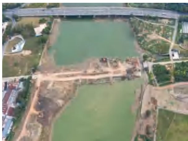
堵坝拆除照片
