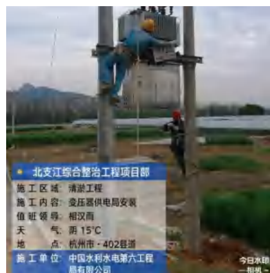
变压器安装照片
