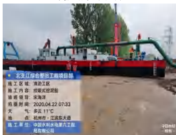
绞吸式挖泥船附件安装照片
