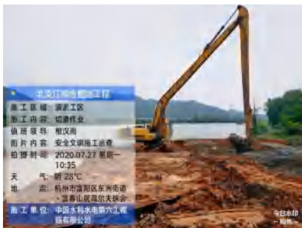
切滩长臂挖机施工照片
