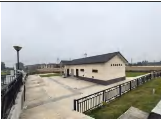
环桥排涝闸站绿化恢复
