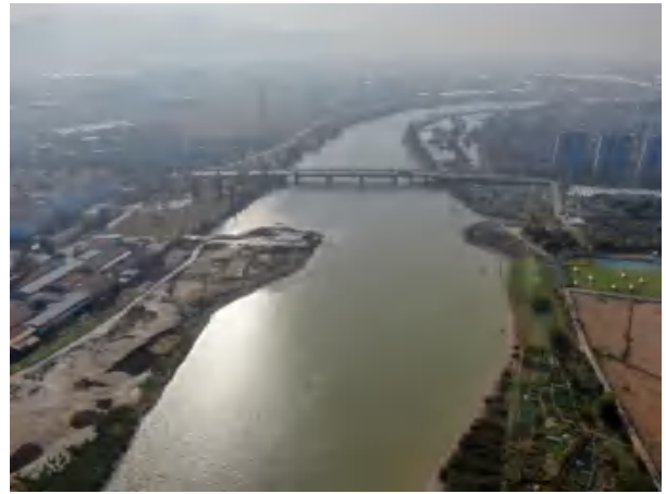
堵坝拆除照片
