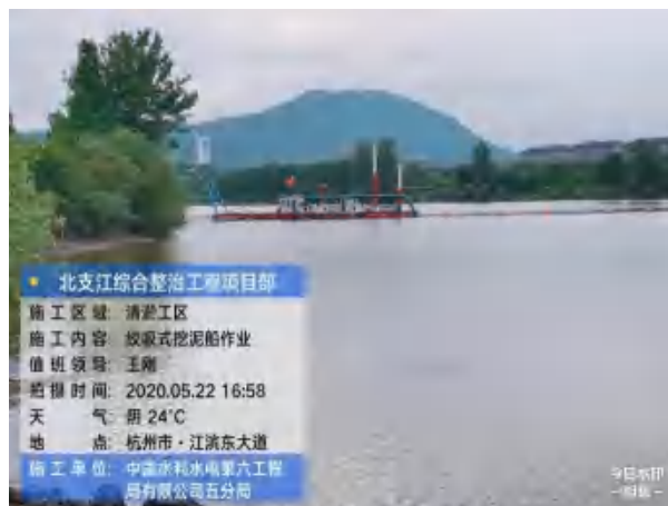
绞吸式挖泥船作业照片
