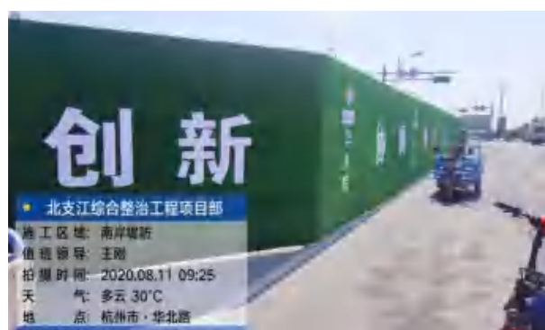
工地围挡封闭
