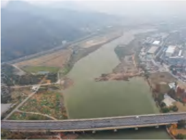
堵坝拆除照片
