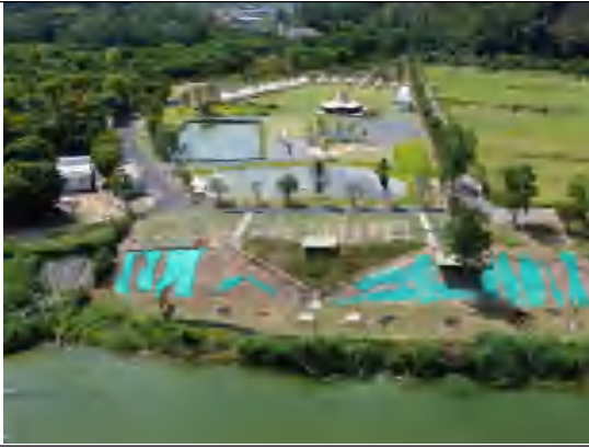
下堵坝拆除后绿化恢复（北岸）
