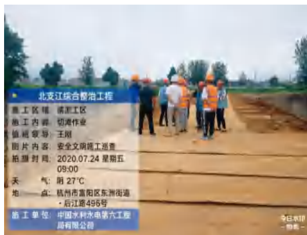
切滩道路施工照片
