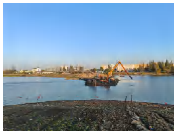
堵坝拆除照片
