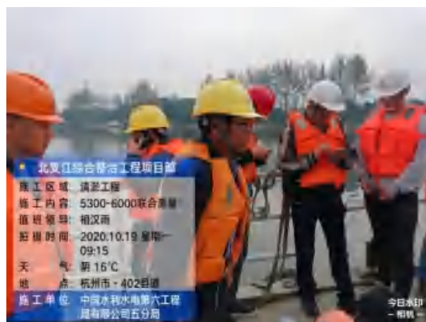
联合测量现场照片
