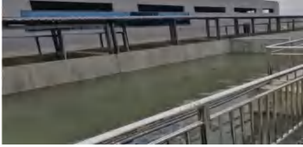
底泥处理厂均化水池
