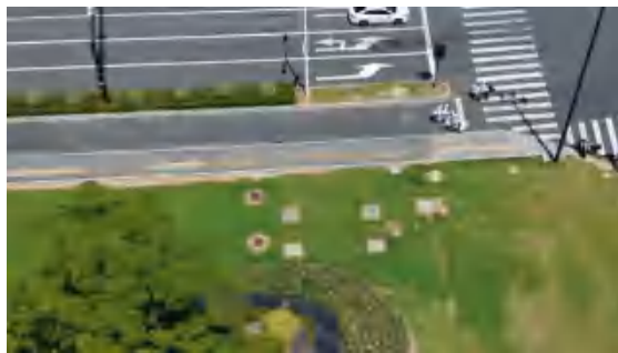
公望大桥桥下地埋式应急池照片
