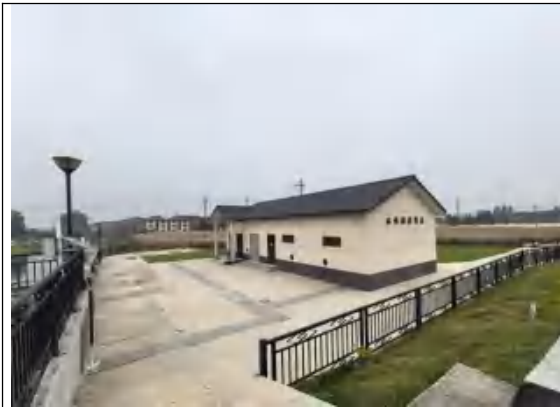
环桥排涝闸站绿化恢复
