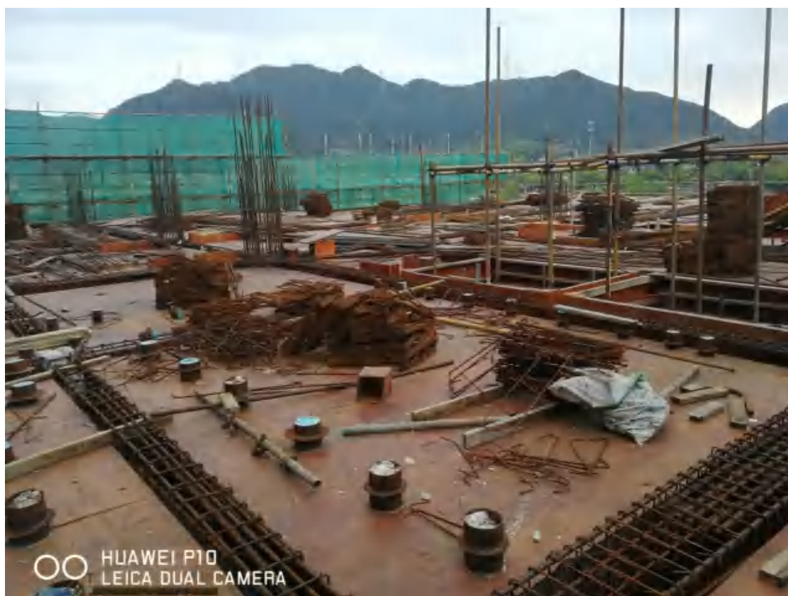
图 4-1 施工期现场照片
